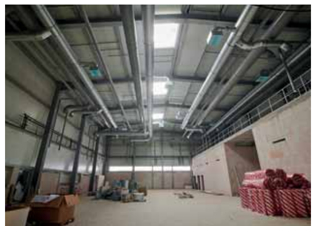
Das Transfer-Technikum im Bau.
